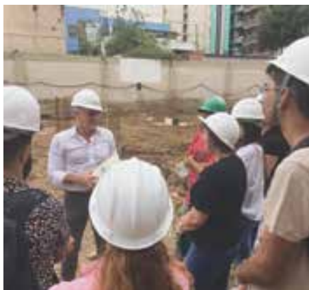
O Engenheiro Nilton Teixeira explica detalhes técnicos da construção do hospital
