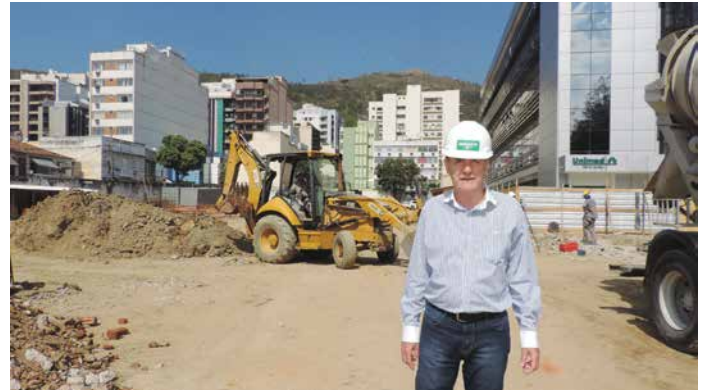
Emilson faz visita técnica ao canteiro de obras
